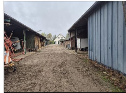
Figuur 2.5 Woning, stallen en schuren aan de IJsseldijk 90 (deelgebied A).
