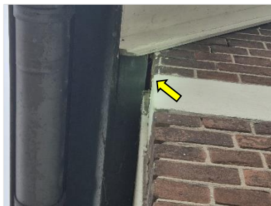
Figuur 4.34 Ruimte langs betimmering in de woning aan IJsseldijk 90 (gebouwcluster 4).
