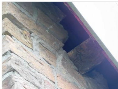
Figuur 4.32 Ruimte onder het dak van het entree gebouw (gebouwcluster 9).
