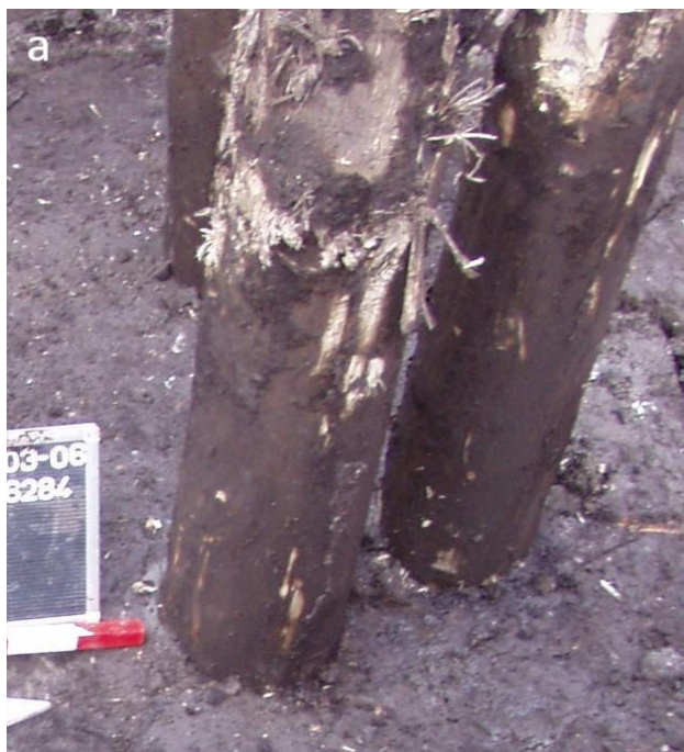
Afbeelding 4: Voorbeeld van verstoring rondom grondverdringende heipalen in veen. Rondom de paal is geen enkele verstoring zichtbaar. Foto: Gemeente Gouda
