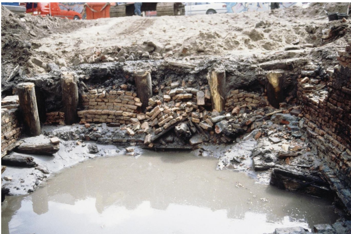
Afbeelding 7: grote verstoring van muurwerk door meerdere heipalen in Amsterdam. Foto: BMA Amsterdam
