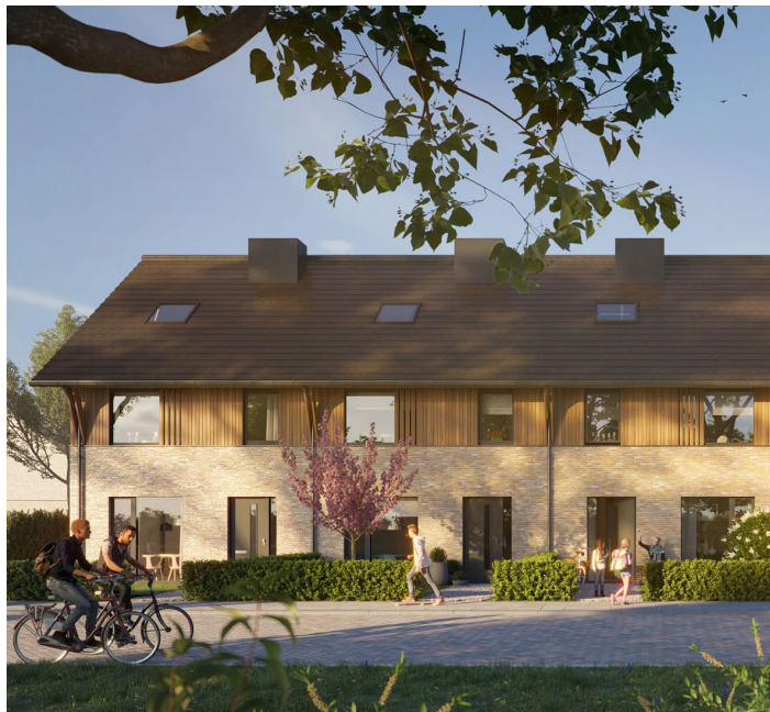
Metselwerk in aardse, natuurlijke tinten met houten delen
