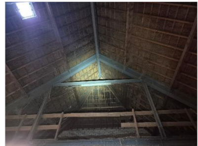
Figuur 4.15 Paardenstal IJsseldijk 88 (gebouwcluster 6).
