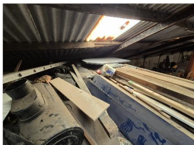
Figuur 4.41 Zoldertje grote schuur ten zuiden van de akkers (gebouwcluster 10).
