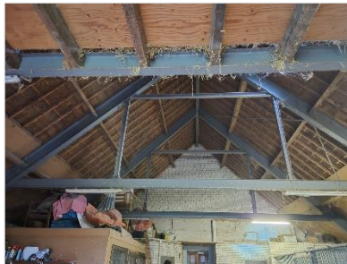
Figuur 4.14 Paardenstal IJsseldijk 88 (gebouwcluster 6).
