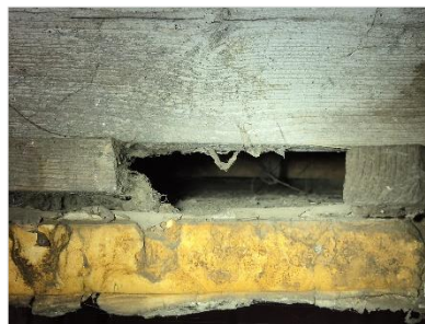
Figuur 4.35 Ruimte in het dak van de schuur aan IJsseldijk 90 (gebouwcluster 4).
