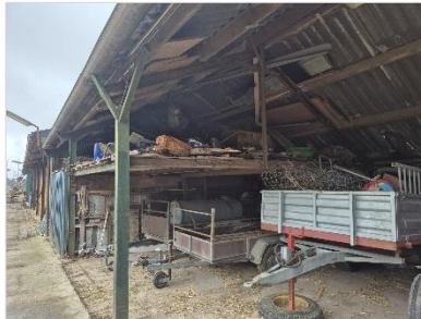
Figuur 4.45 Schelft in schuur IJsseldijk 90 (gebouwcluster 4).
