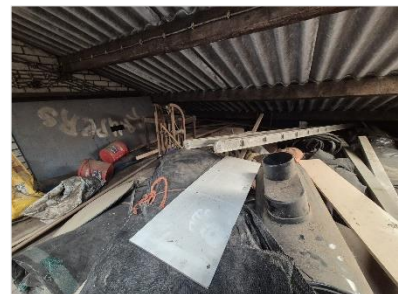
Figuur 4.40 Zoldertje grote schuur ten zuiden van de akkers (gebouwcluster 10).
