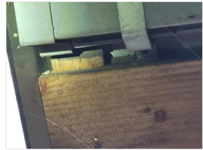
Figuur 4.8 Ruimte achter regenpijp van schuurwoning IJsseldijk 88 (gebouwcluster 7).
