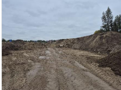
Figuur 4.54 Zand en -hopen op bouwdepot.
