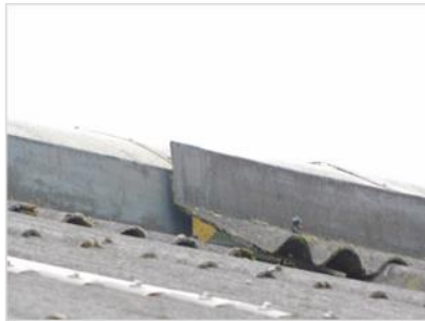
Figuur 4.13 Schuur naast akkers met opening in dak (gebouwcluster 10).
