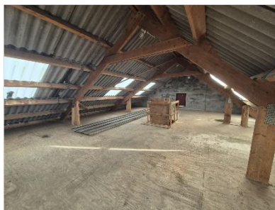
Figuur 4.17 Zolder van schuur ten zuiden van akkers (gebouwcluster 10).
