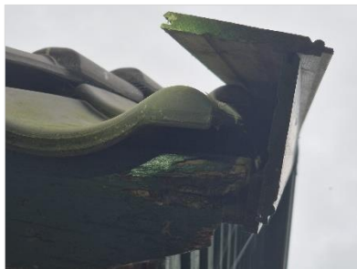
Figuur 4.9 Toegang tot dakruimte in schuurtje IJsseldijk 88 (gebouwcluster 6).
