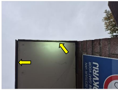
Figuur 4.28 Ruimte onder betimmering in het clubhuis van Voetbalclub Avw'66 (gebouwcluster 9).
