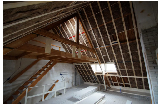
voorbeeld van verbouwing onder een dakkap
