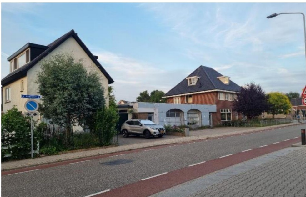
Huidige situatie ter plaatse van het projectgebied (bron: Jan Jansen bouwkundig adviseurs).
