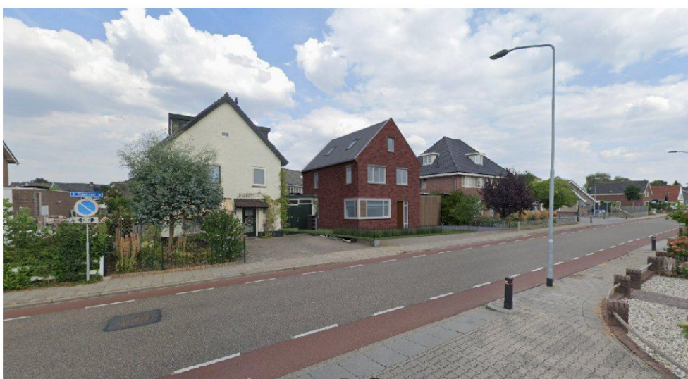
Aanzicht vanaf de Hoevensstraat (bron: Jan Jansen bouwkundig adviseurs).
