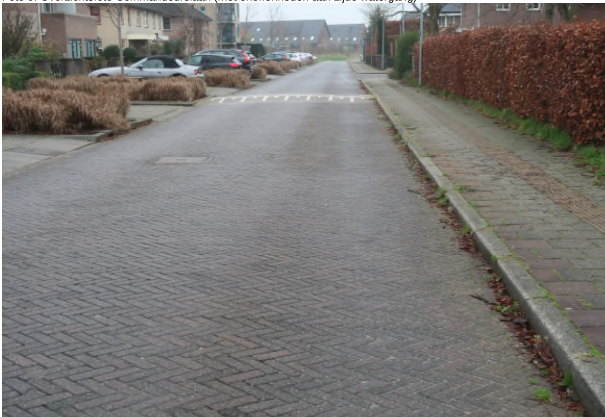
Foto 10: Oneffenheden De Ganzepoel, Het Geerken (Niet opgemerkt door Inspectrum)
