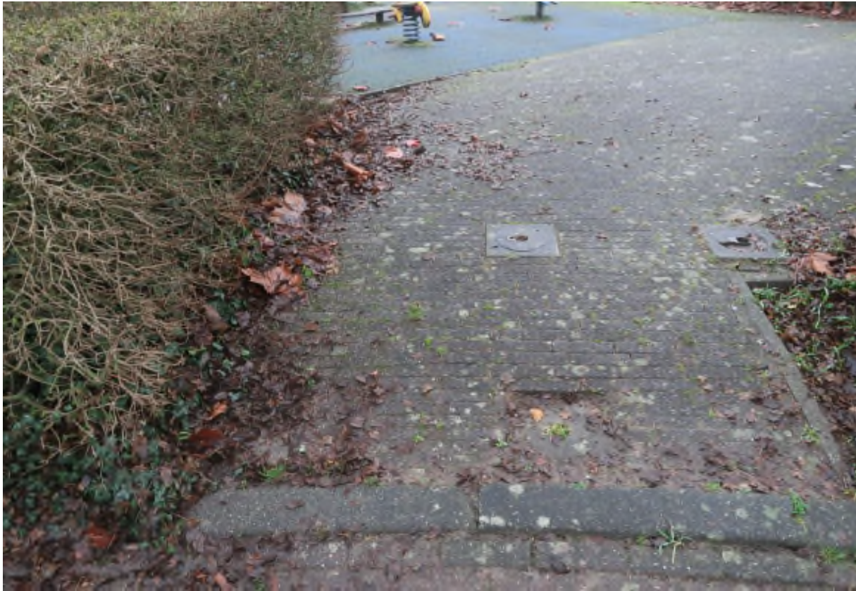
Foto 7: Speelplaats De Hoge Hoeve met onvlakheden elementen
