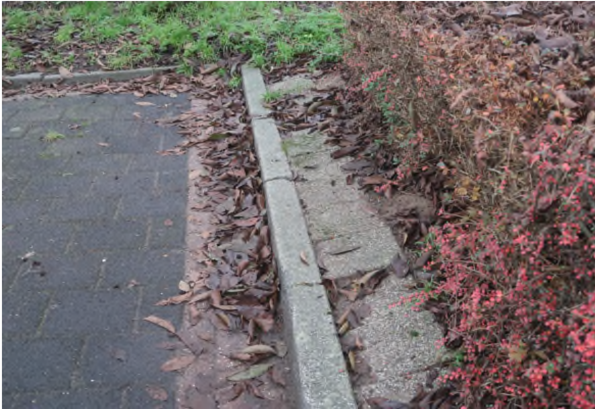
Foto 3: Ernstige vervorming uitstapstrook parkeervak Vockemaet
